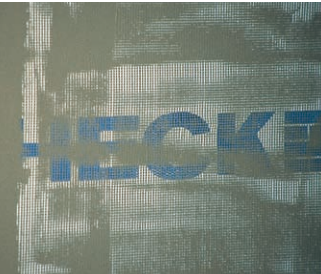
③ Nochmals komplett HECK K+A aufziehen.
