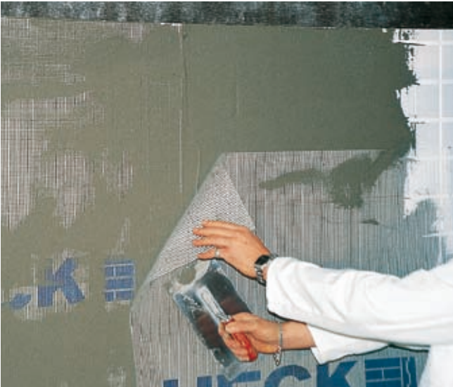
① HECK K+A auf Dämmplatte aufbringen.
